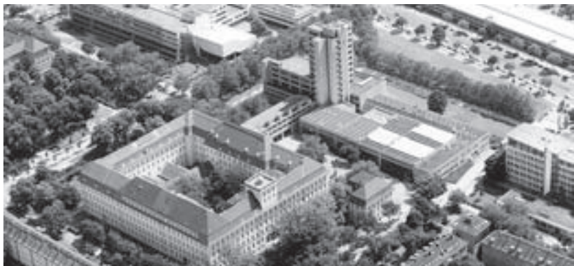
Der TFH Campus mitten in Berlin: Nach der Vorlesung sind die Kulturangebote und die Szene der Hauptstadt gut zu erreichen. Die U-Bahn und Parkplätze gibt es direkt vorm Haus.
