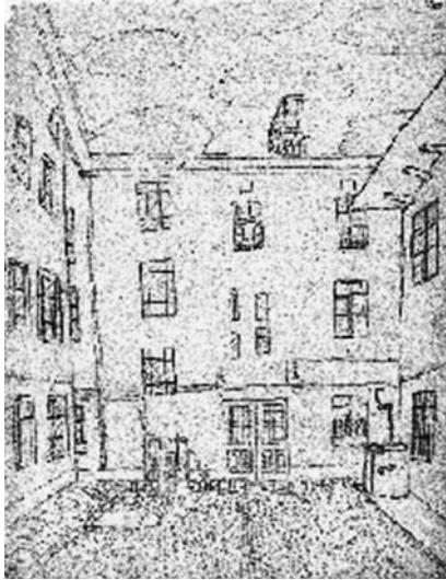
Rückseite des Gebäudes
