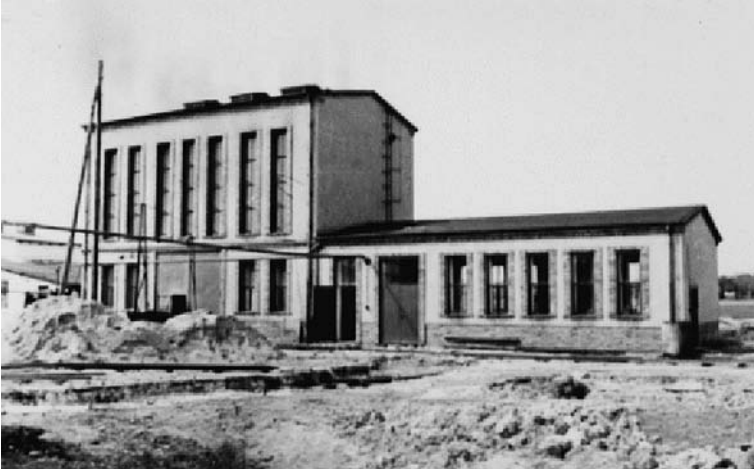
Entwickler- und Kompressorengebäude
