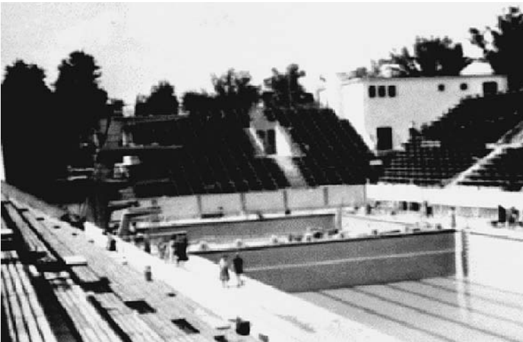
Ansicht des Schwimmstadions
