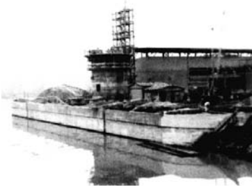
Zementwerk im Bau
