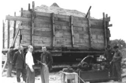
Belastung des Versuchspfahles
