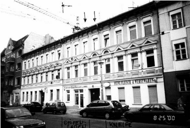
Ansicht Heinersdorfer Straße 33a
