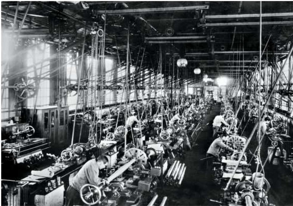
Bild 1.5: Fabrikationshalle mit Transmissionsantrieben
