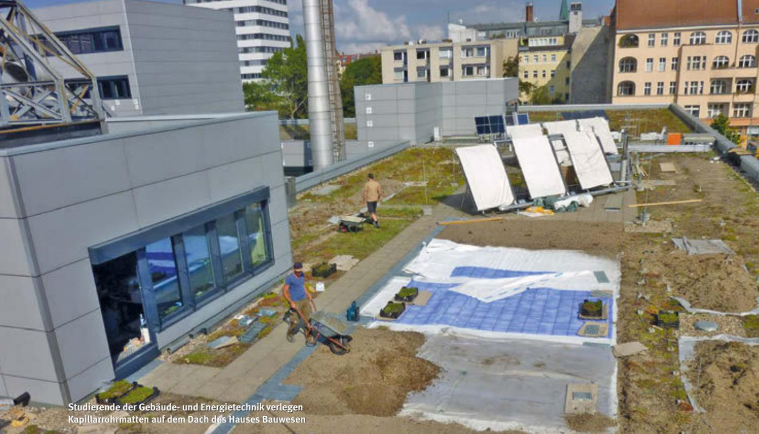
Studierende der Gebäude- und Energietechnik verlegen Kapillarrohrmatten auf dem Dach des Hauses Bauwesen
